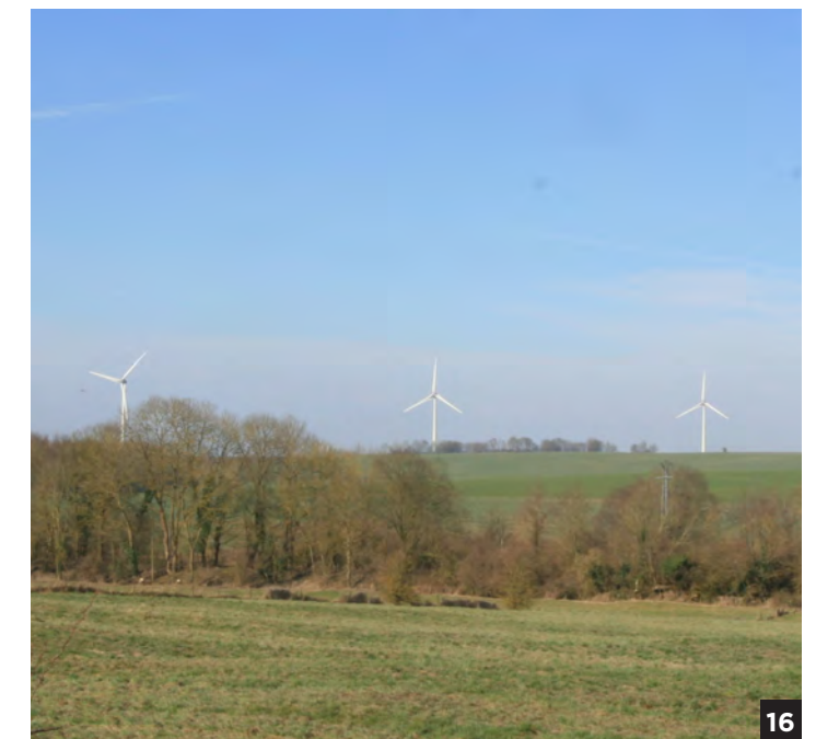
Parc éolien de Pontru Alignement de 8 machines le long de l'A26
